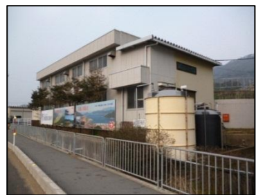
汚泥処理設備棟
