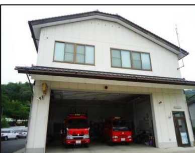
野田川第四分団消防車庫
