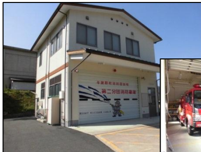
加悦第二分団消防車庫
