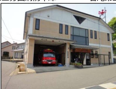
野田川第一分団消防車庫
