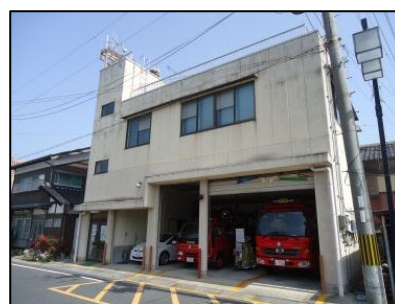
岩滝第三分団消防車庫
