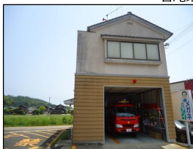
岩滝第四分団消防車庫
