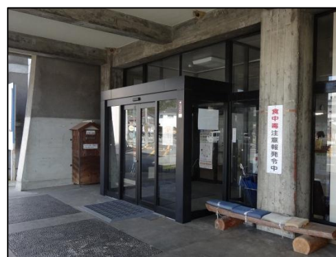
平成 18 年の合併時に自動ドアに改修した 野田川庁舎玄関
