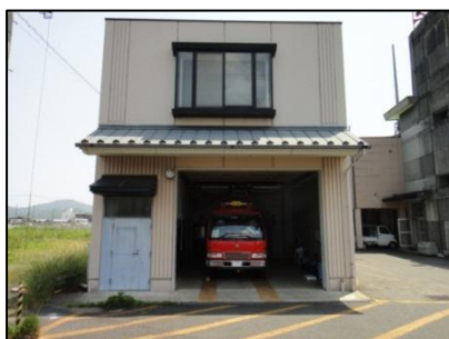
野田川第三分団消防車庫
