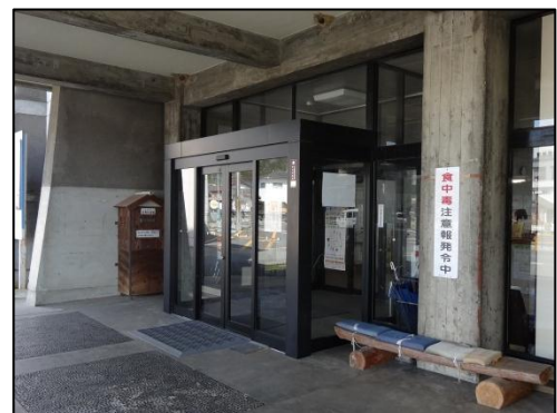
平成 18 年の合併時に自動ドアに改修した 野田川庁舎玄関
