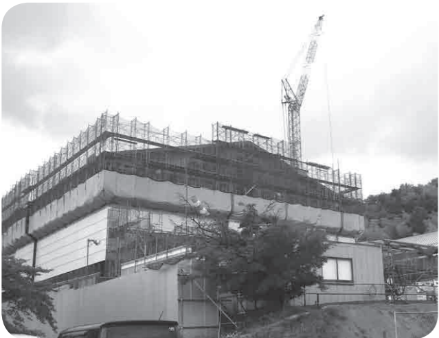
加悦中体育館工事進む
