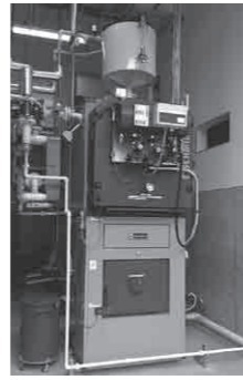
木質チップボイラー
