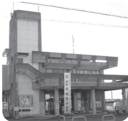
老朽化により廃止する野田川庁舎
