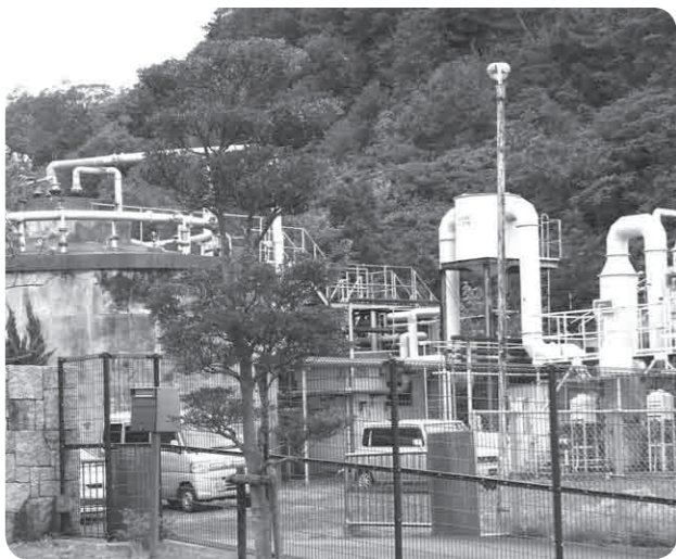
下水道宮津湾浄化センター
