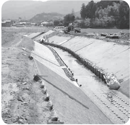
岩屋川改修工事
