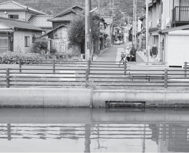
高潮対策が望まれる浸水地域
