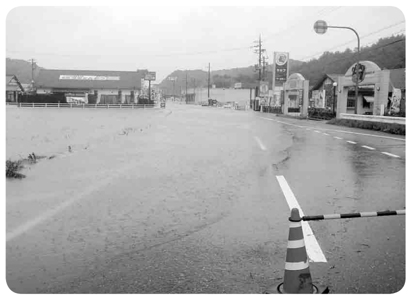
冠水した国道176号線(石川地区)
