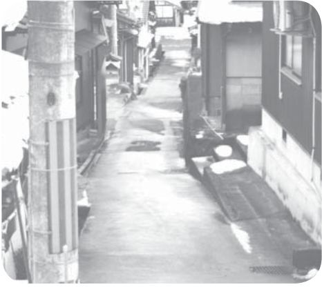
住民協力で施工された道路（後野）
