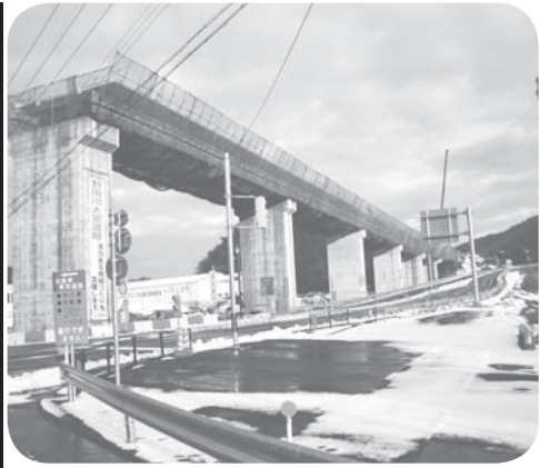
工事中の与謝天橋立インター
