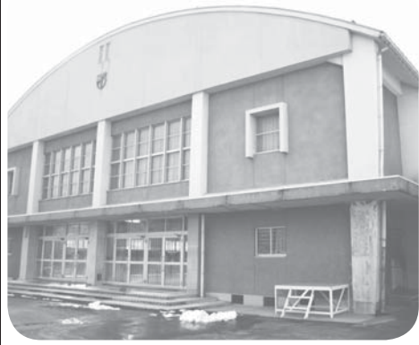
加悦中学校体育館
