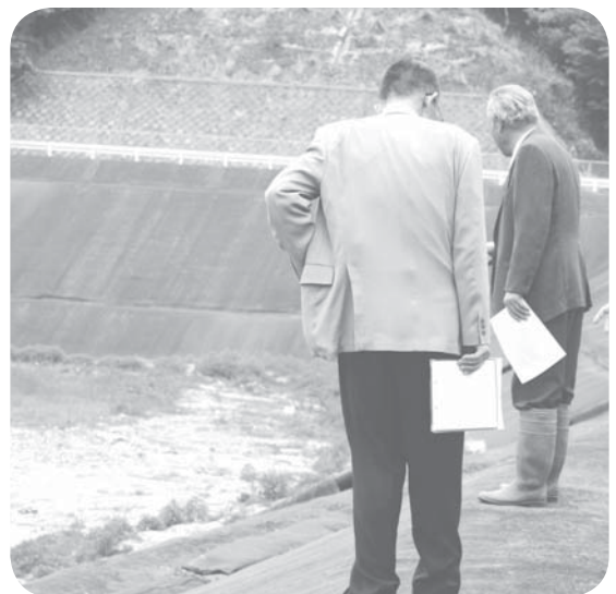
ようやく再開した野田川最終処分場
