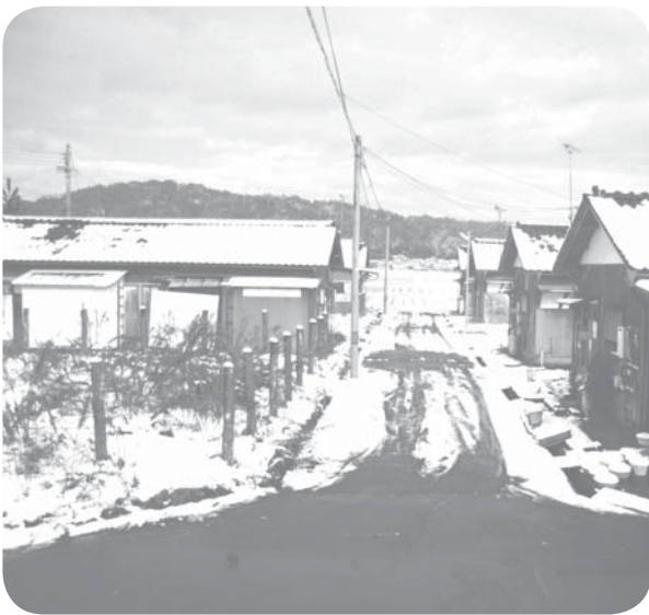
改善が求められる町営住宅
