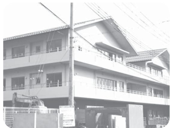
建設が進む「やすらの里」
