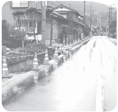
地元要望にこたえて施工される工事
