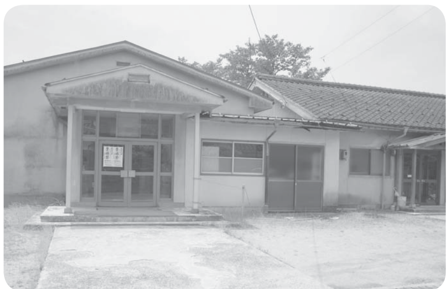
老朽化した梅谷会館が新築される
