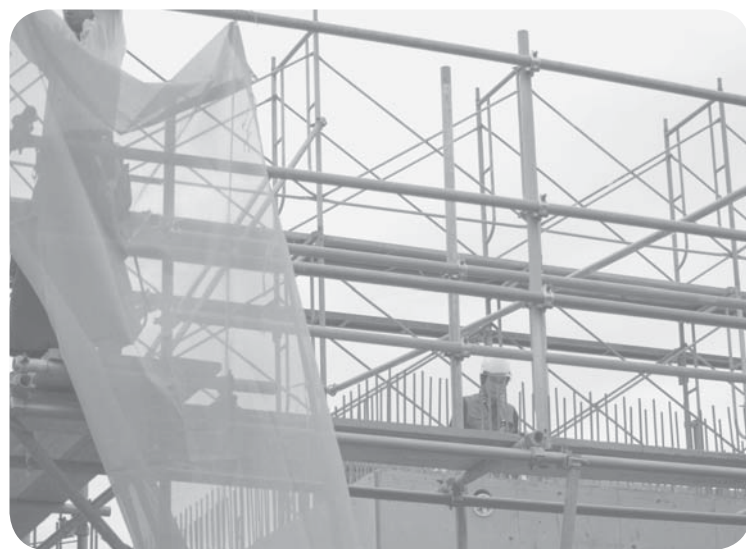
地域共生型福祉施設「やすらの里」の建設現場
