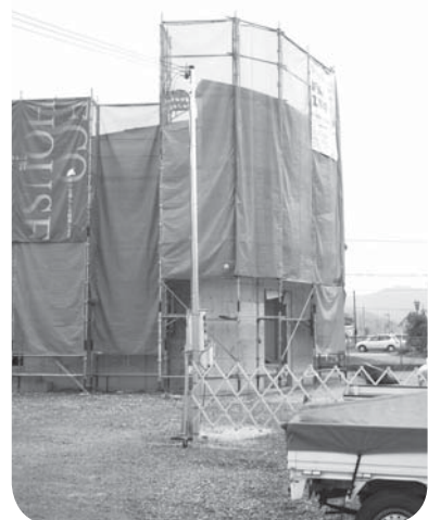
改修が進む民間住宅
