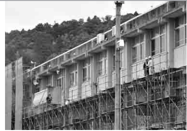
左/加悦谷ショッピングセンターウイルから町営バスひまわりに乗り込む買い物客ら 右/耐震工事中の山田小学校。現在ではすべての小学校の耐震化が完了しています
