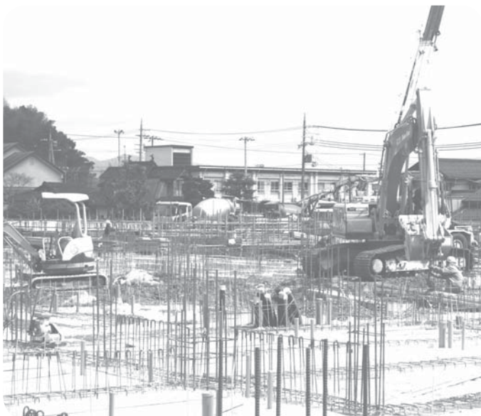
工事が進む地域共生型複合福祉施設（やすらの里）
