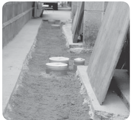
住宅改修制度で下水道工事
