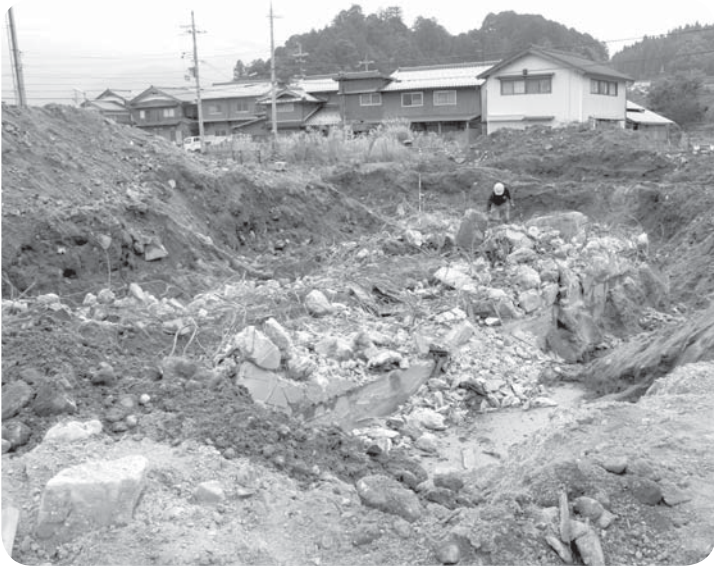
早期完成が待たれる造成工事
