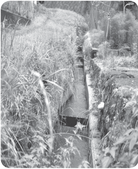
地域再生事業（水路整備）
