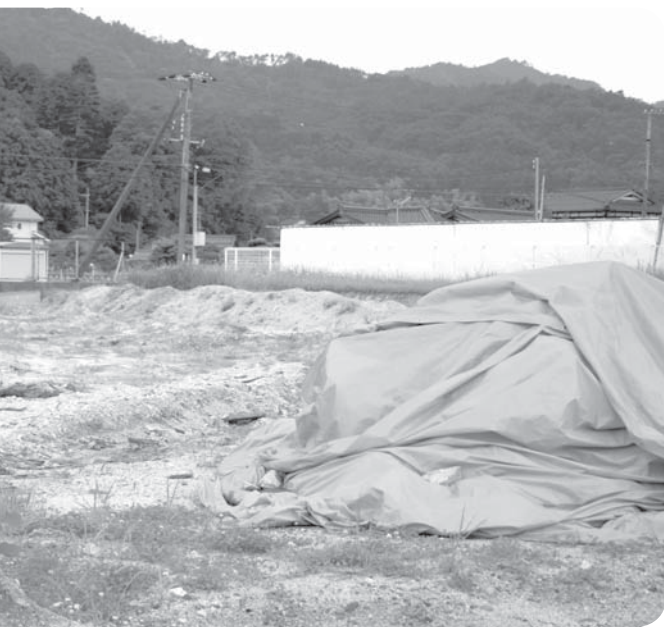
ガレキが出土した福祉施設造成地
