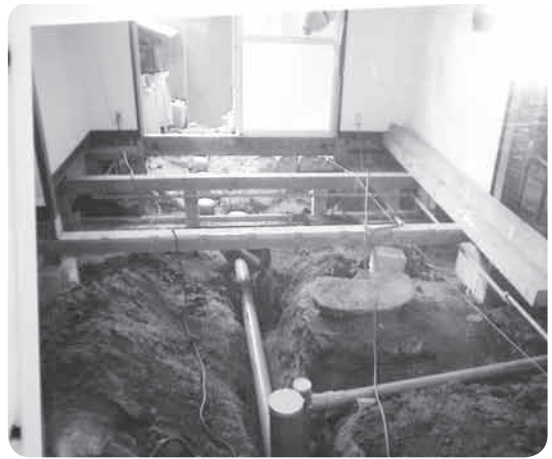
住宅改修助成で進む下水工事
