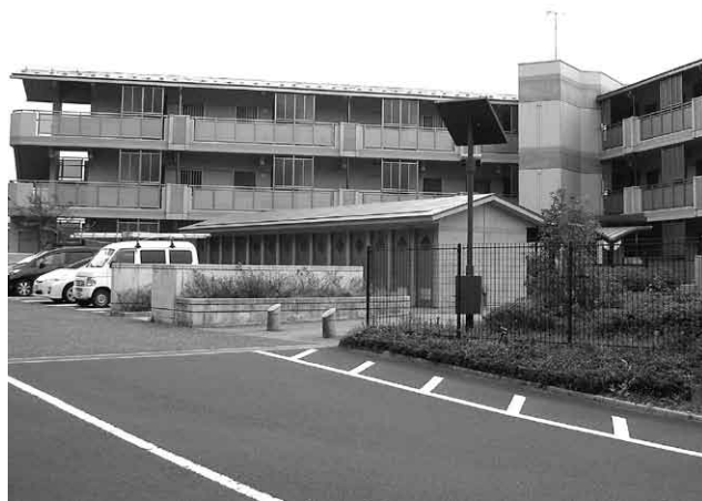
工事が始まる町営住宅
