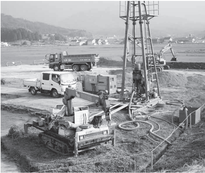
新加悦浄水場整備
