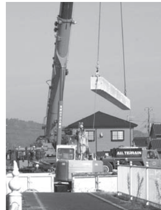
進む改修工事
