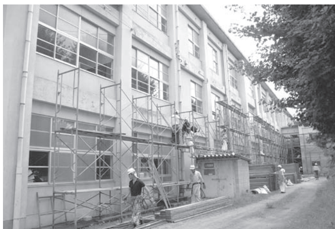
三河内小学校の耐震工事
