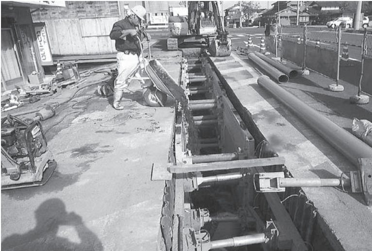
進む下水道工事
