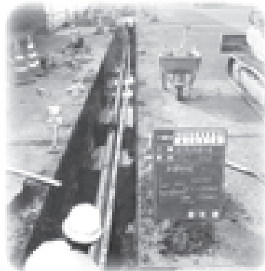
不況下で進めぬ水洗化
