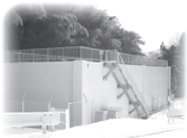
完成した配水池（幾地）
