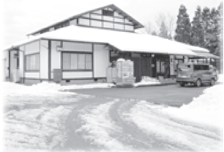
改修された 温江 山の家
