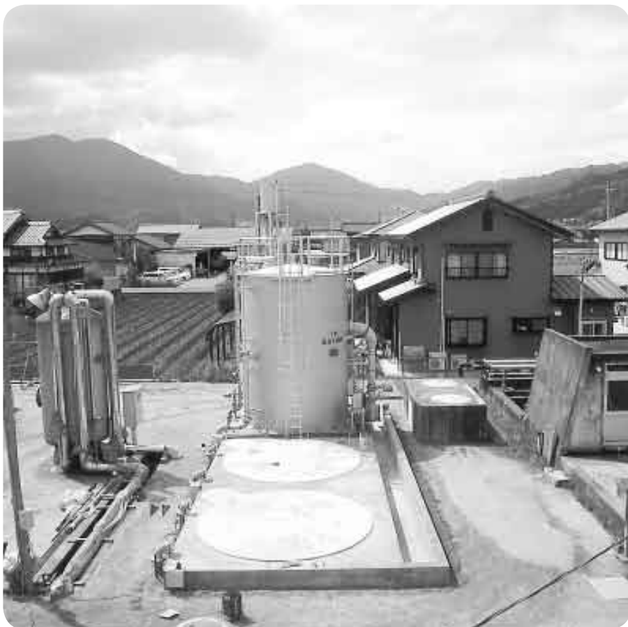
改良工事が進む算所浄水場
