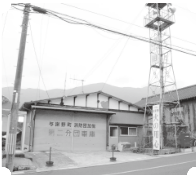
老朽化した消防車庫
