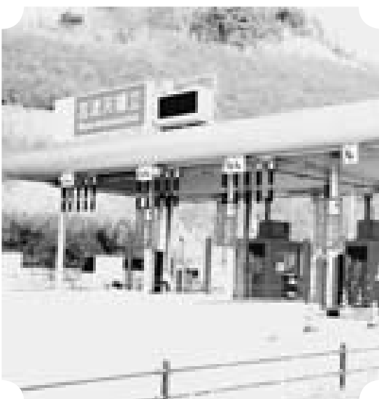
宮津インターチェンジ料金所
