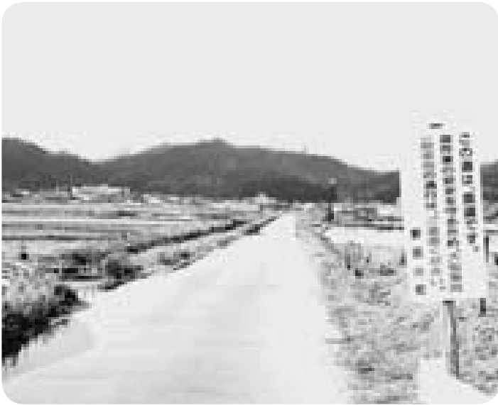
舗装された農道
