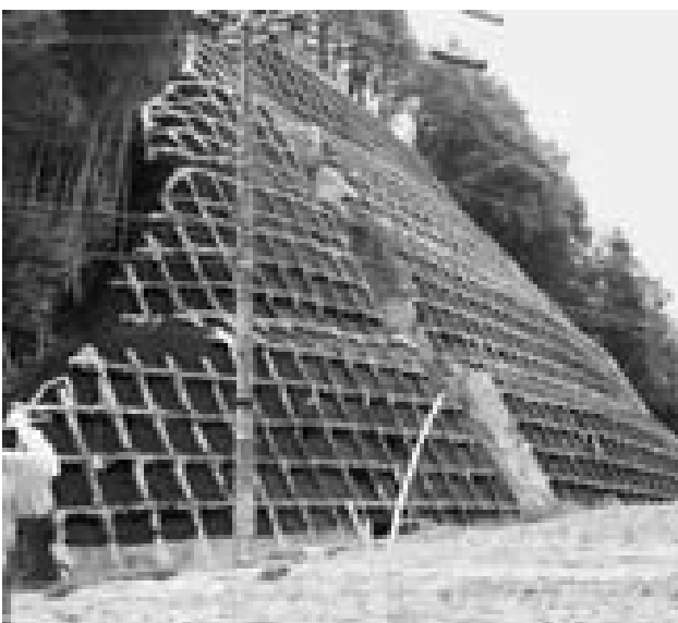
完成なった山手線法面
