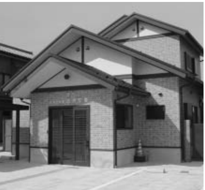
↓加悦町商工会館横に新築移転した加悦交番
