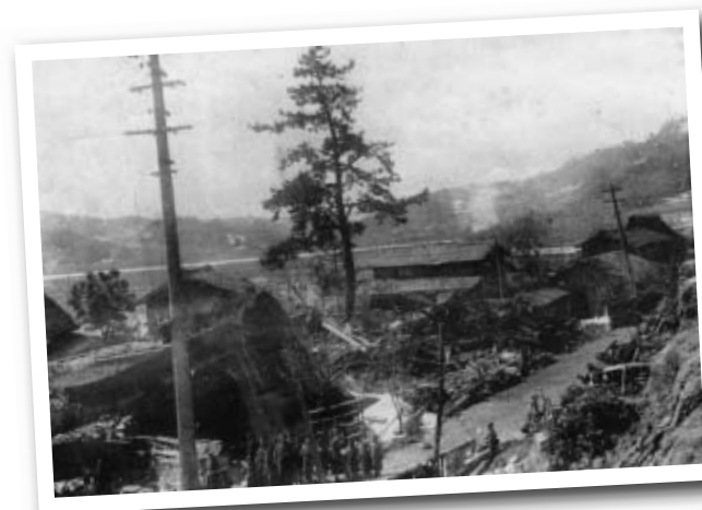
↑弓木地区、糸徳の前の被害の様子
