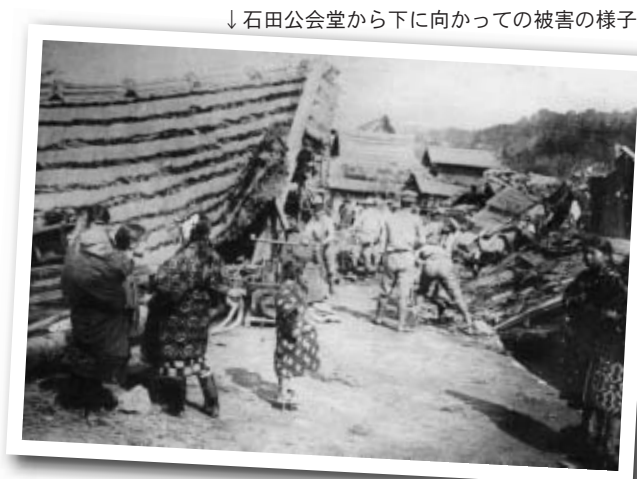
↓石田公会堂から下に向かっての被害の様子
