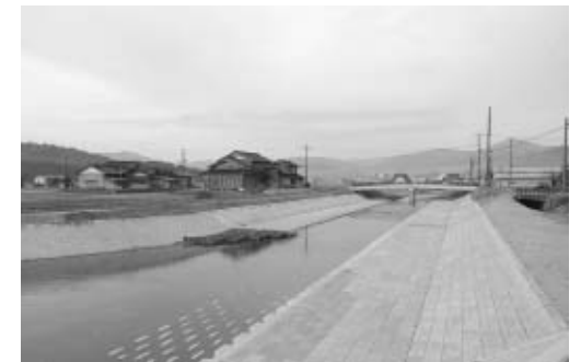
↑完成した香河川バイパス河川
