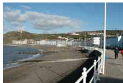
海岸沿いのマリントラス
