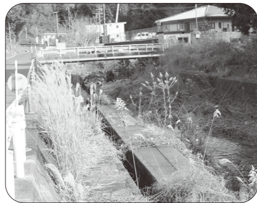
男山浄水場までの浚渫を
